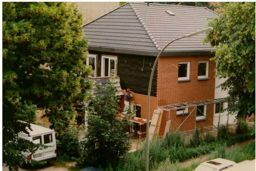
Das Haus in der Verklammerung und kurz vor der Fertigstellung
