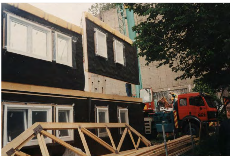
... und das Dach liegt auch schon bereit.
