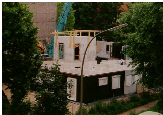
Das Einpassen der Hauswände unter Zuhilfenahme eines schweren Baukranes
