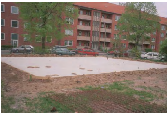
Der erste Schritt zum HSK Schachzentrum: Die Bodenplatte
