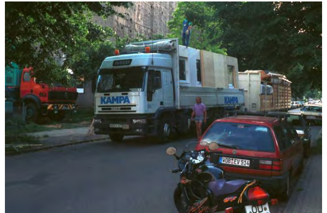
weitere Wände werden angeliefert
