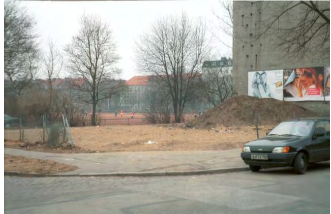
Der vorbereitete Bauplatz
