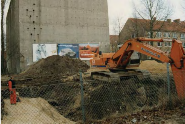
Die erste Überraschung: Ein altes Kellergemäuer macht einen Bodenaustausch notwendig
