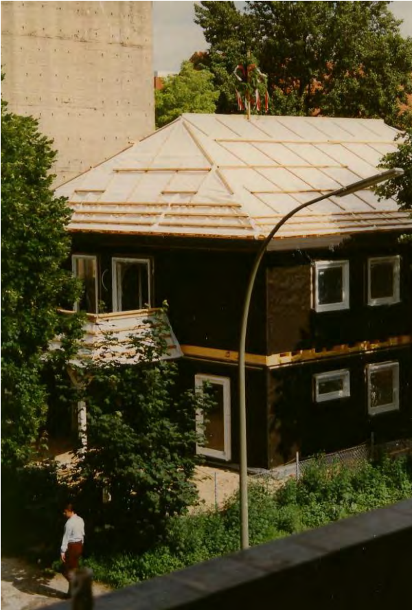
Der Richtkranz weht auf dem neuen HSK Schachzentrum.
