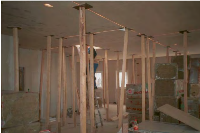
Das Obergeschoss bekommt seine Decke
