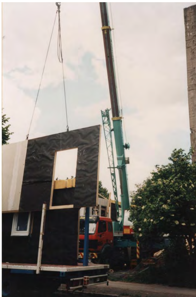
Abladen der Hauswände ...
