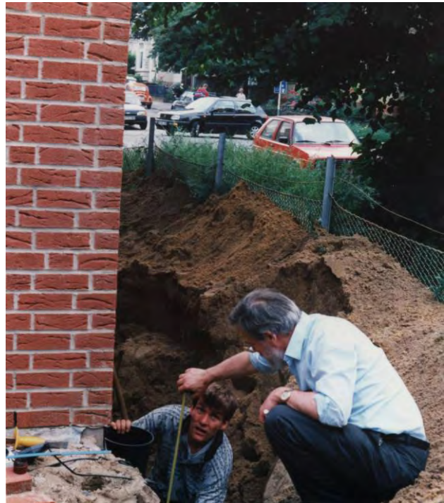
Udo Figger und Wilfried Mordhorst beim Rohrverlegen
