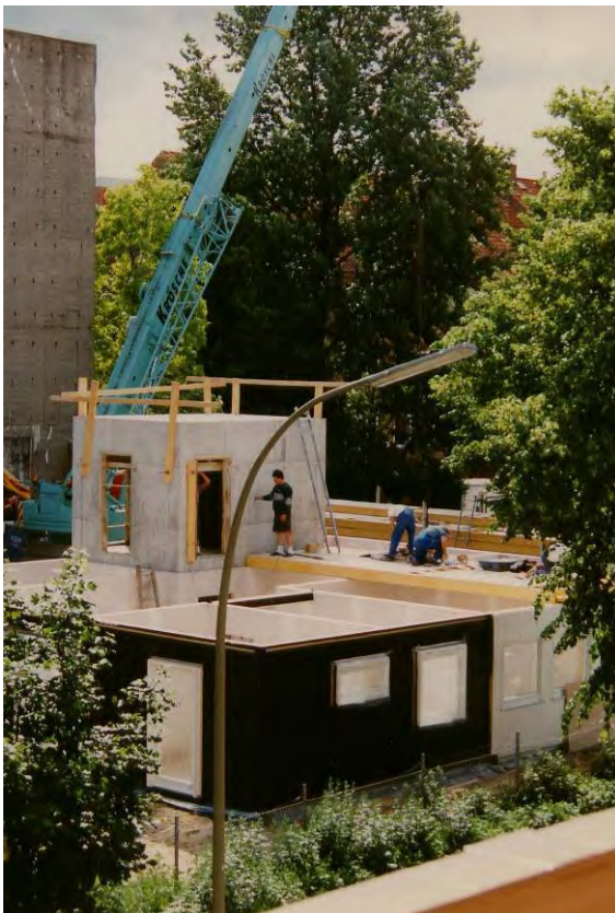
... und gedeiht mit Hilfe eines schweren Baukrans
