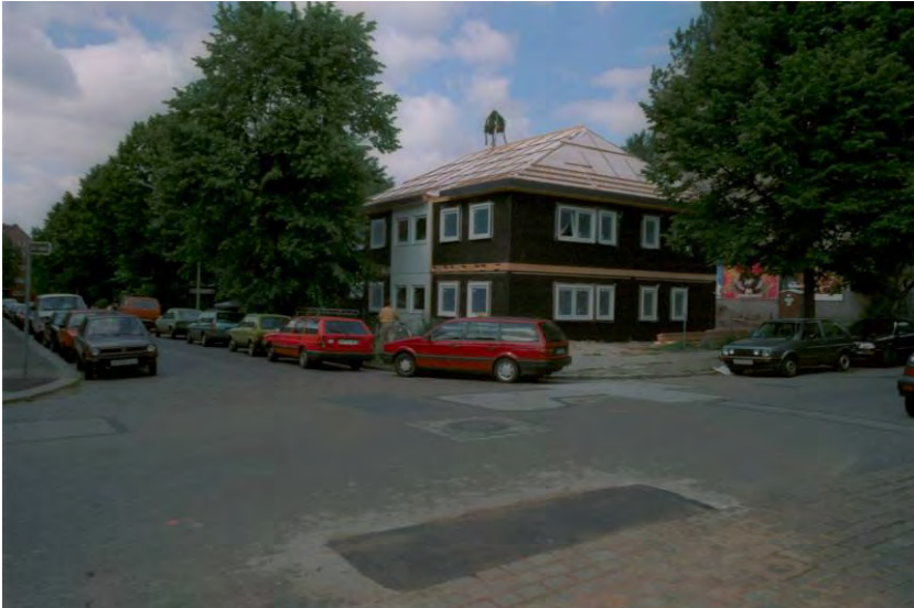
Richtfest am 14. Juni 1996 nach nur zwei Tagen Bauzeit; zeitgleich mit außerordentlicher Mitgliederversammlung
