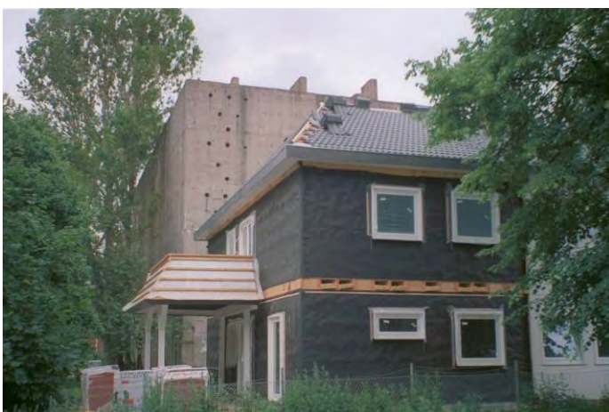
Das Dach ist eingedeckt
