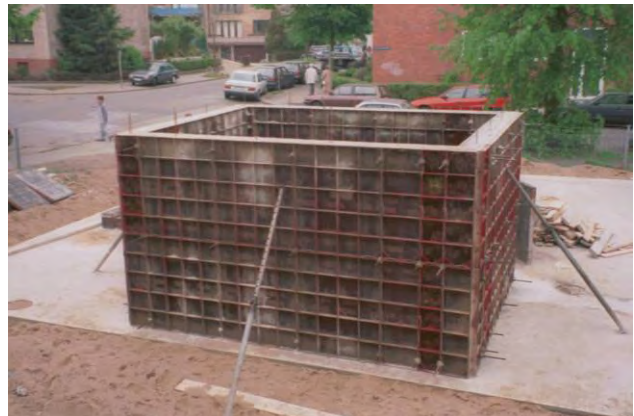
Wegen der Feuersicherheit: Verschalung für das zum Treppenhaus, das aus Beton bestehen musste.
