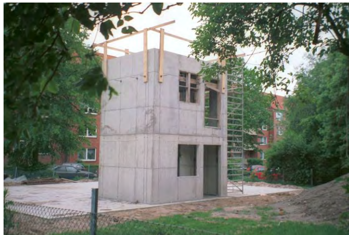
Im Rohbau fertig: Das Treppenhaus
