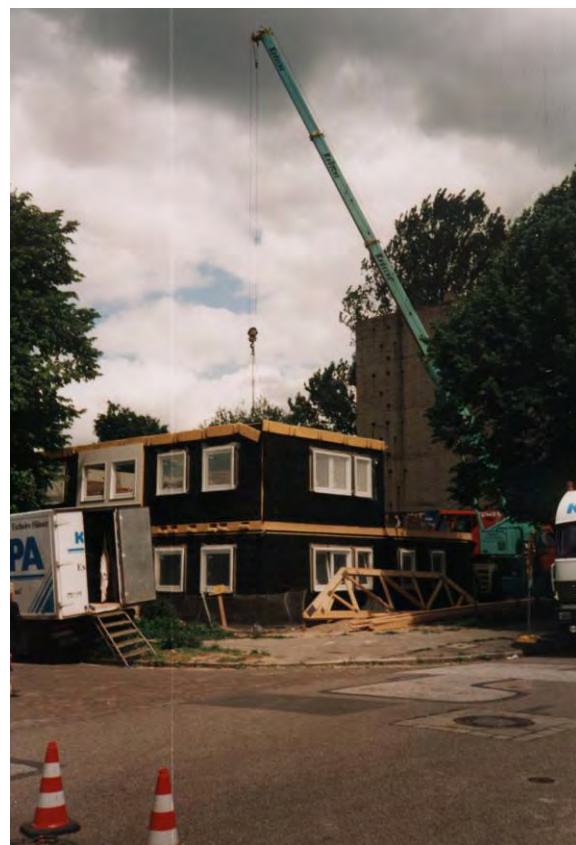
Das Obergeschoß ist fast fertig
